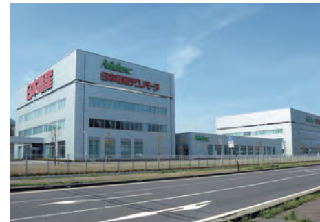
Fukui Technical Center (Headquarters and R&D) 本社・福井技術開発センター
