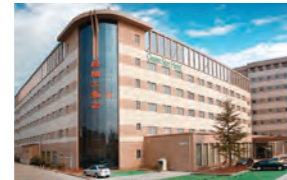
Nidec Total Service (Zhejiang) Corp. Green Sun Hotel 日本電産総合サービス(浙江)有限公司 綠陽大飯店(ホテル)
